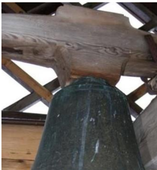
Mellomaldarklokke frå Hegge stavkyrkje. Åket/opphenget er tilpassa ei kronelaus klokke.
