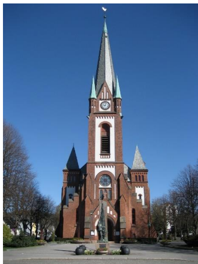
Sandefjord kirke – godt synlig i bybildet
